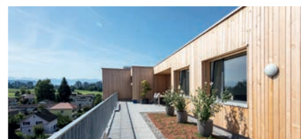
Betriebsgebäude Beer Holzbau
