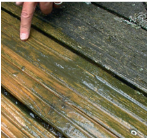
Unter Pflanzgefässen bilden sich gerne Algen oder siedeln sich Flechten an. Durch Unterlegungen von mindestens 20 Millimetern wird dies vermieden oder zumindest minimiert.
