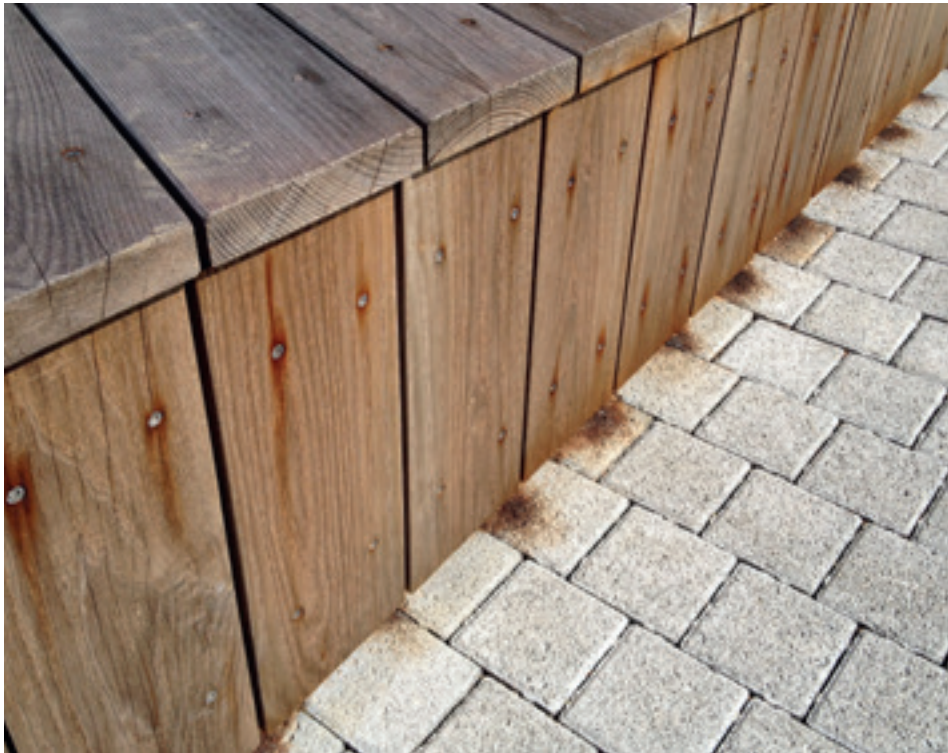
Oben: Vorsicht bei benachbarten Bauteilen und deren Eigenschaften. Die Eichenbalken (Brücke) respektive deren natürliche Inhaltsstoffe verursachten diesen Schaden.
